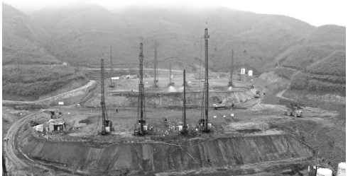
贵州天柱项目现场照片
